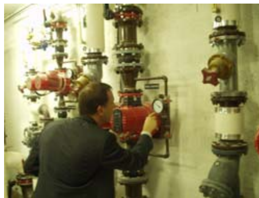
Diagnostic de réseaux d'eau.
