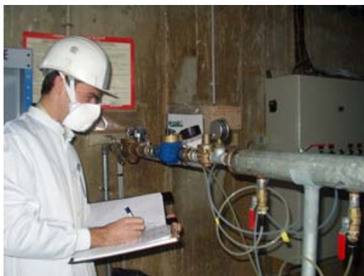
Diagnostic de réseaux d'eau.
